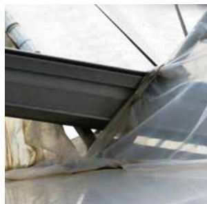
隙間がないか確認
