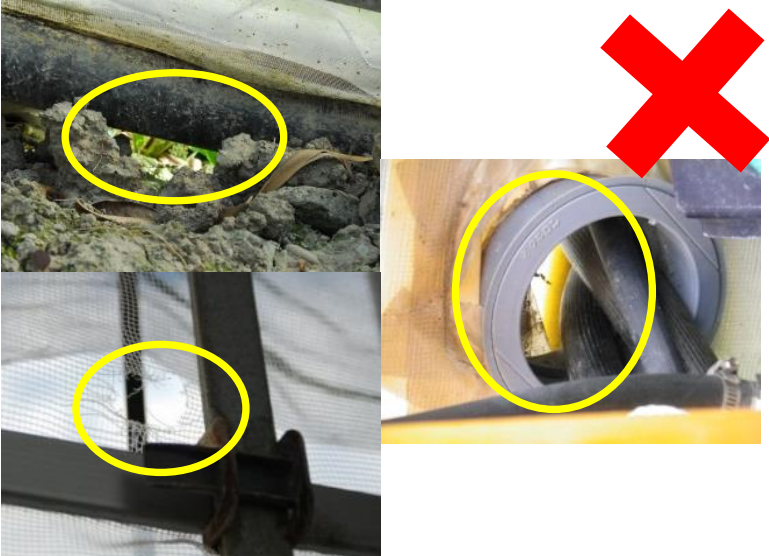
ハウスと地面の間やビニールの破れなどの開口部 (速やかにふさいでください)
