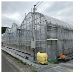
側窓・出入り口
